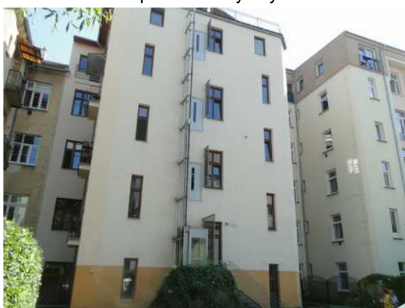
Dvorní pohled na bytový dům
