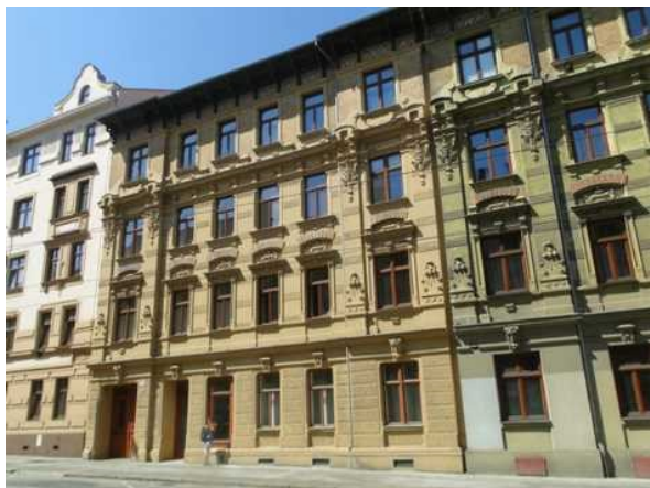
Uliční pohled na bytový dům
